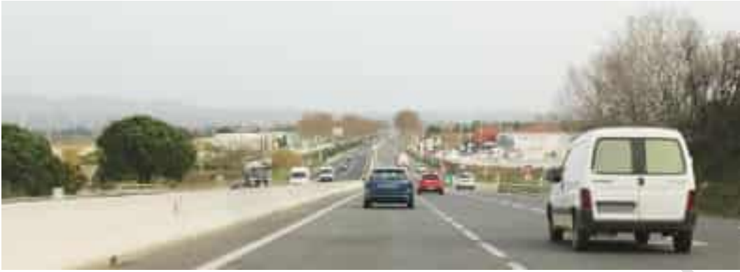
Figure 5 : Route RD900, entrée sur le territoire SCoT depuis la ville voisine de Perpignan – Source : AURCA
