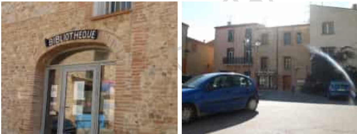
Figure 10 : Des façades édifiées en cayrou à Clairà – Source : AURCA
