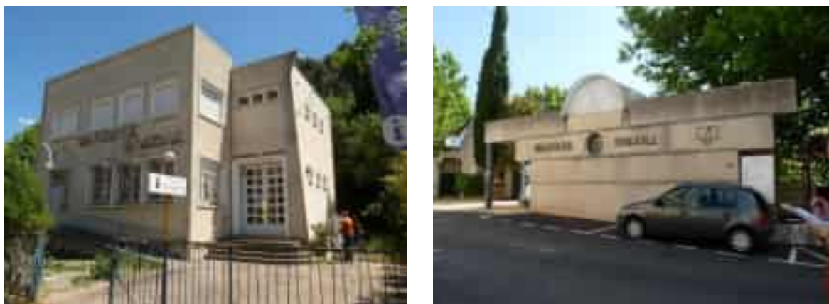
Figure 63 : Bibliothèques municipales de Durban-Corbières et de Tuchan - Source : AURCA
