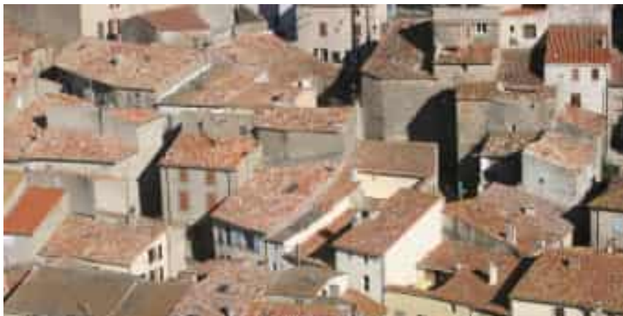
Figure 14 : Toitures anciennes à Durban-Corbières Source : Mairie de Durban-Corbières
