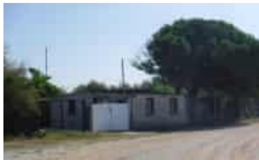
Figure 11 : Cabane à l'anse Roquette - Source : DDTM
