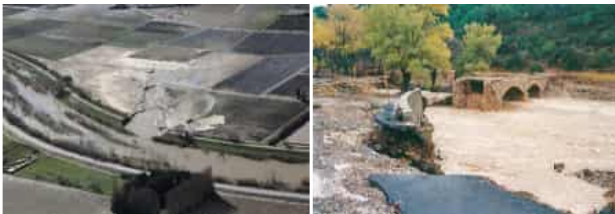
Figure 22 : Brèche dans les digues de l'Agly à Pia en mars 2013 (à gauche) et pont détruit par la crue du « Petit Verdoble » à Tuchan en 1999 (à droite)
